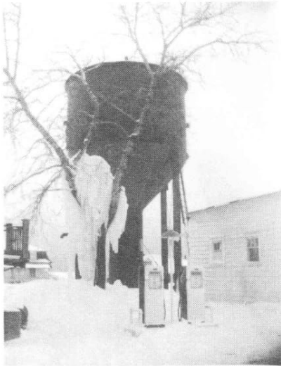
Le réservoir à eau qui alimentait les engins à vapeur.
