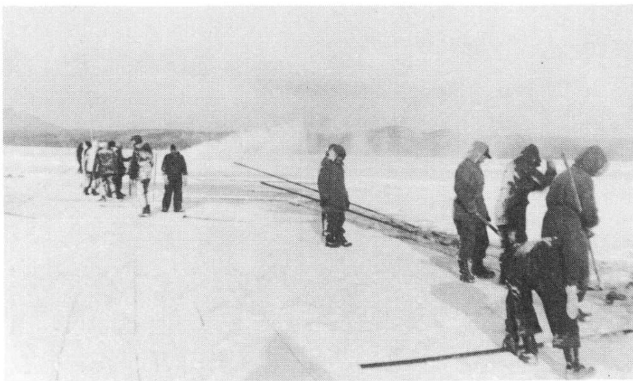
Mise en bloc par les ouvriers.
