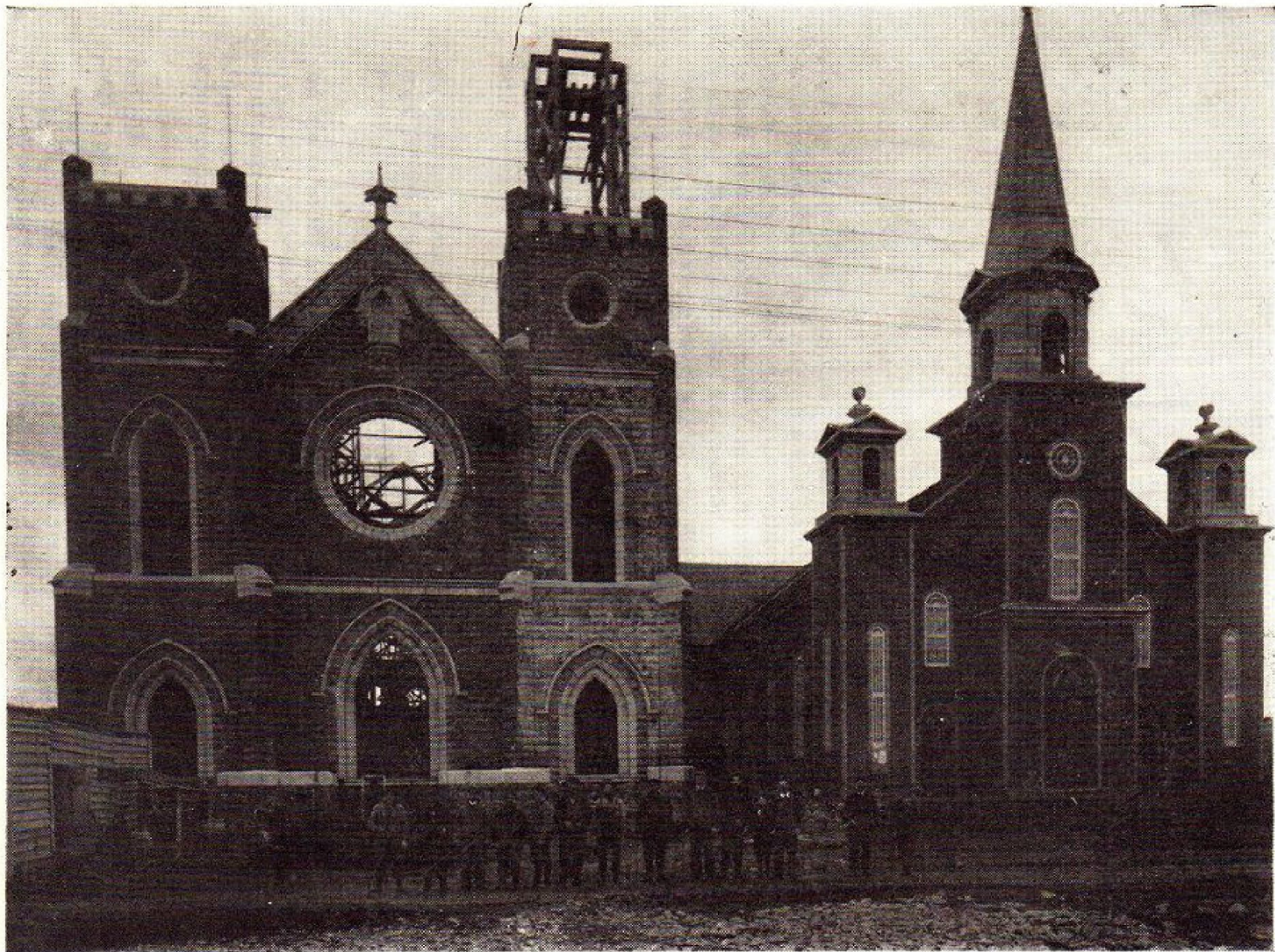
La première église et la nouvelle (en construction) (Photo en 1915)
