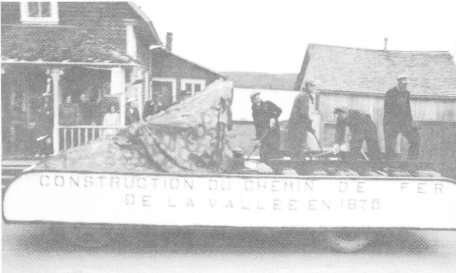
La construction de l'Intercolonial (Ste-Florence).
